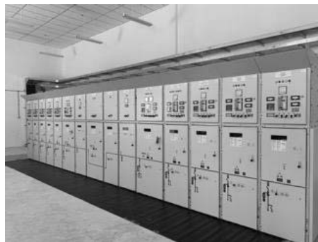
MV switchgear
